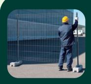
Grazie alla semplicità dei pali autoportanti ad incastro, i pannelli possono essere montati con estrema facilità anche da una sola persona.
